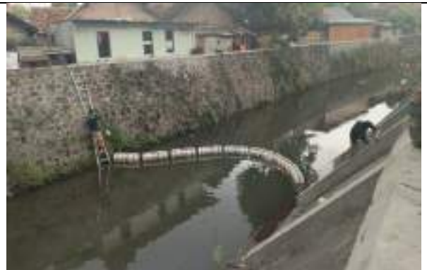
Selatan Jembatan Tegal Gendu, Kel. Giwangan, Kem. Kotagede
