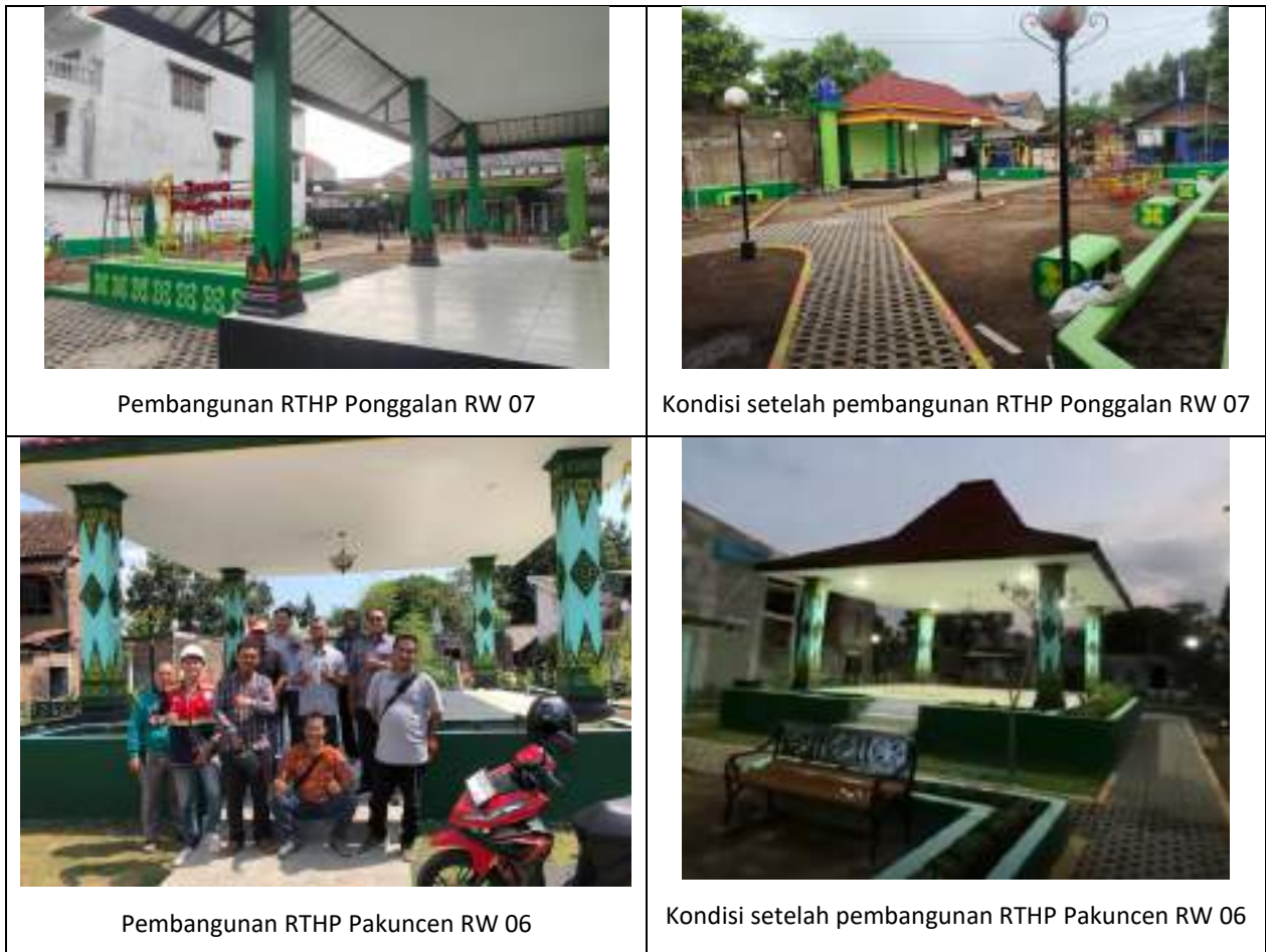
Gambar 3. 25 Proses Pembangunan RTHP di Tahun 2025
