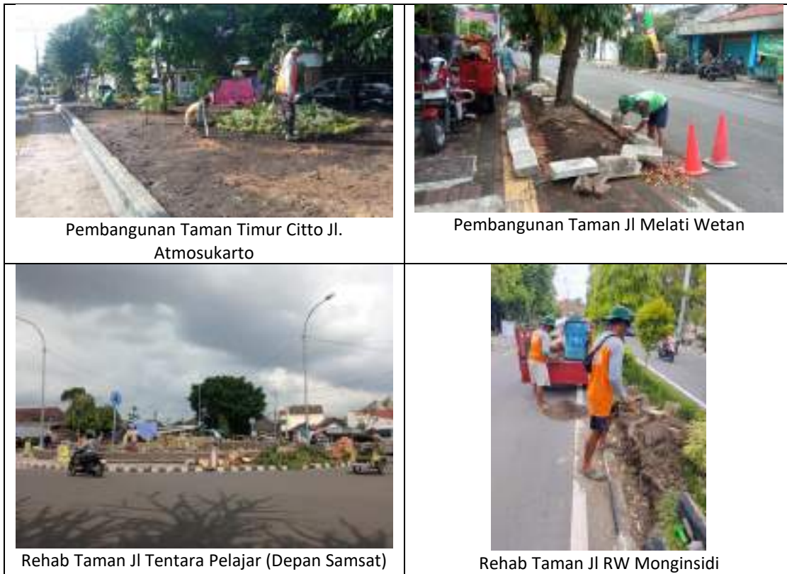
Gambar 3. 32 Pembangunan dan Rehab Taman Kota pada Tahun 2025
