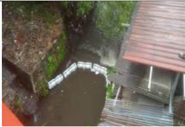
Jembatan Garuda Merdeka (Bangunrejo), Kel. Karangwaru, Kem. Tegalrejo
